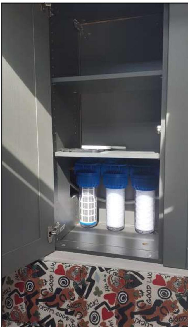
Dispositif de filtration aval et de potabilisation de l'eau, sous l'évier.
